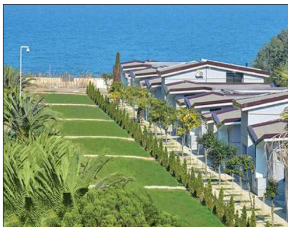
▲ مرکز آموزشی فرهنگی شماره ۵ (بهشهر): ۳۱۵۰ مترمربع (مساحت زمین ۳۰۰,۰۰۰ مترمربع)
